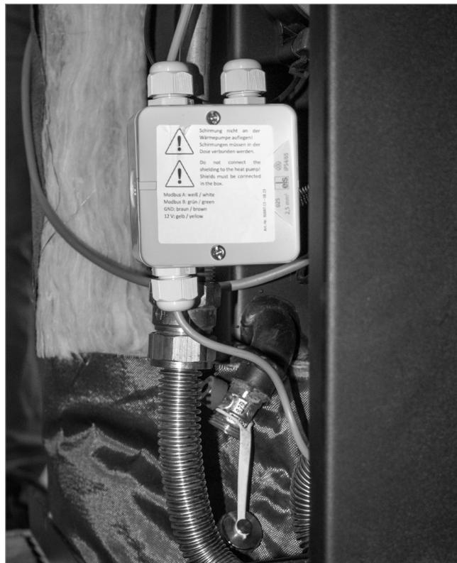
Abb. 16: Modbus Anschlussbox am Vorlaufrohr in SolvisBruno
