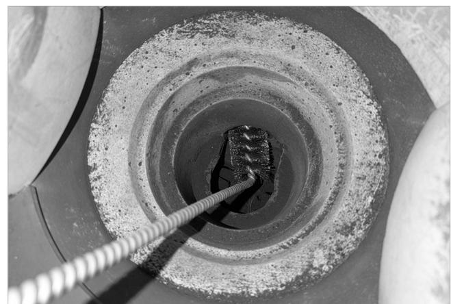
Abb. 16: Brennkammer/Rost reinigen
