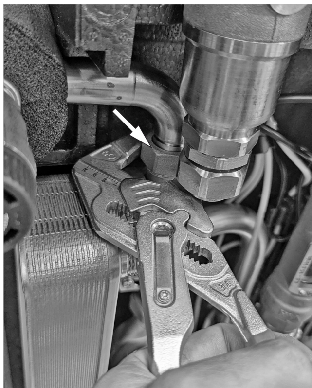
Abb. 6: VL-Rohr an der SÜS lösen
