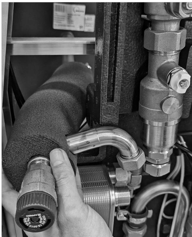
Abb. 7: Demontage Solar-Vorlauf
