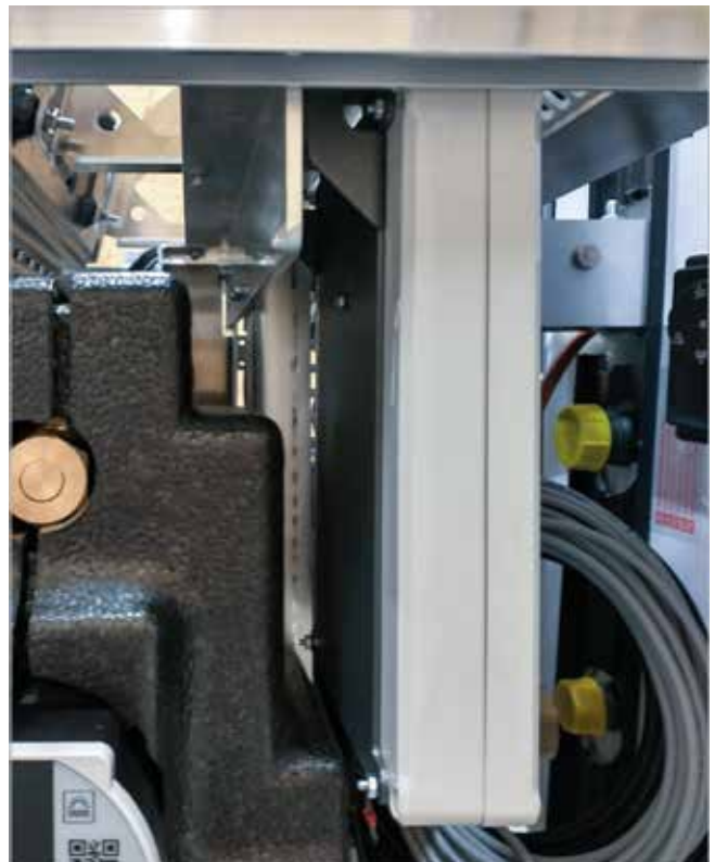
Abb. 11: Leistungselektronik montiert (SolvisMax)
