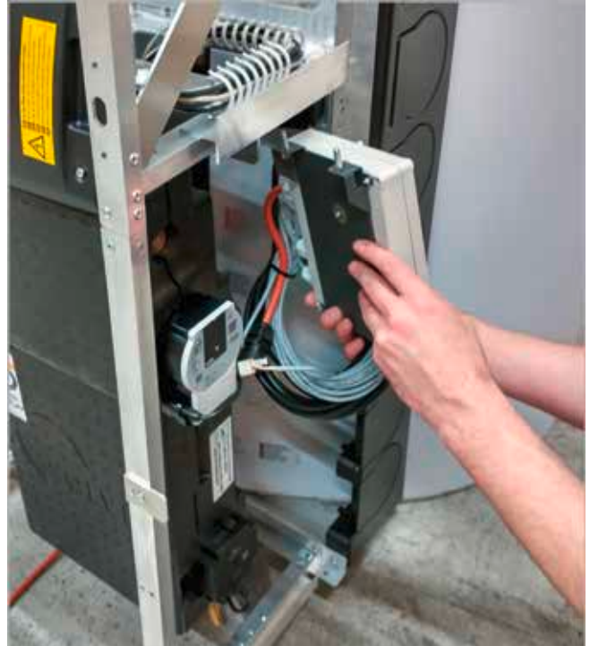
Abb. 10: Leistungselektronik im Lademodul positionieren (SolvisMax)
