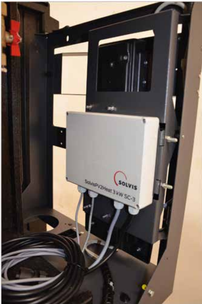
Abb. 9: Montage der Leistungselektronik im Gestell (SolvisBen)
