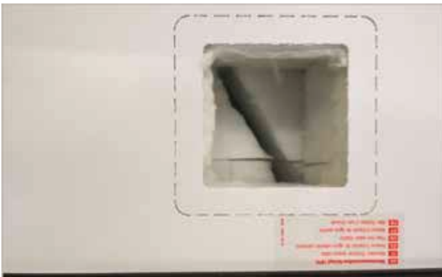
Abb. 4: Dämmmaterial heraustrennen
