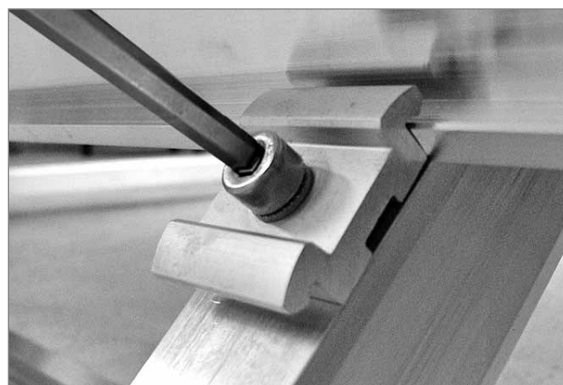
Avvitare saldamente i morsetti inferiori
