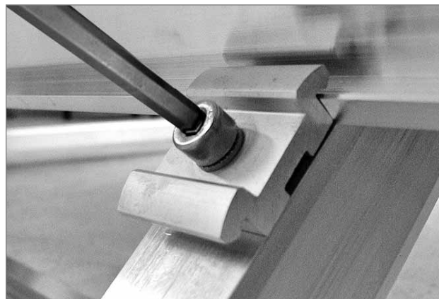
Aparafusar completamente as peças de fixação inferiores
