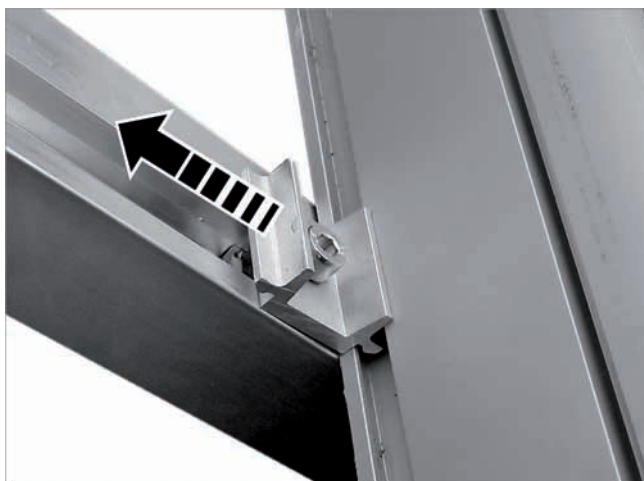
Abb. 1: Alte Kollektoren zusammen mit den Mittelklemmen entfernen
