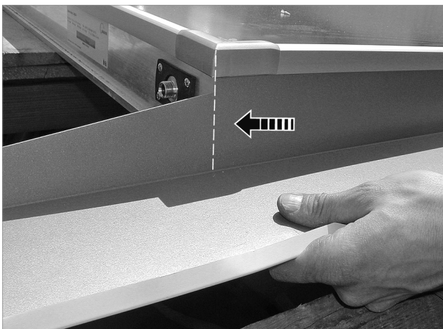
Abb. 57: Oberes Seitenblech gegen den Anschlag nach oben schieben
