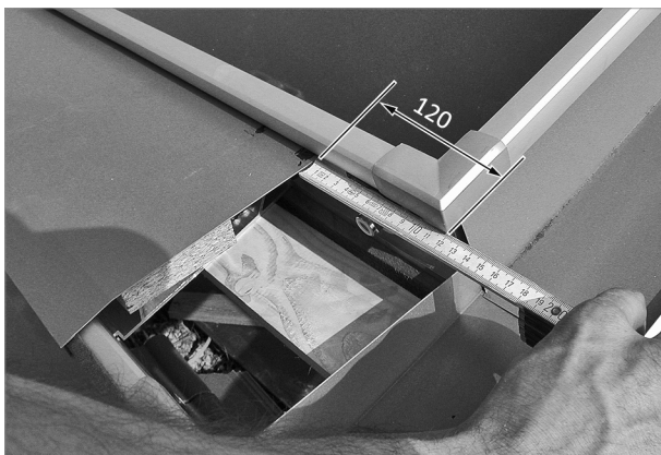
Abb. 71: Blech auf Abstand zur Außenkante bringen
