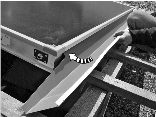
Abb. 64: Blech an die Nut unterm Clip-Profil setzen, dann an den Kollektor anlegen
