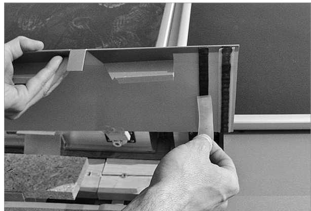
Abb. 73: An der Unterseite des Kreuzungsbleches Schutzstreifen abziehen
