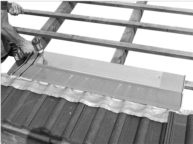
Abb. 47: Erstes Blech rechts auflegen und anschrauben
