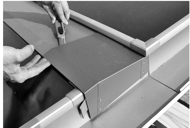
Abb. 77: Bei nachträglichem Zugang: Klebeverbindung zwischen den Blechen lösen ...
