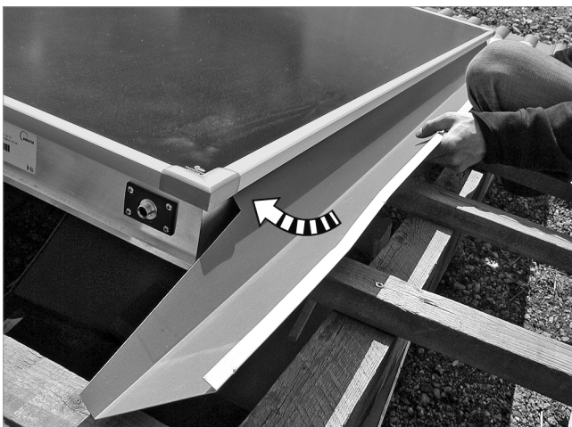
Abb. 56: Blech an die Nut unterm Clip-Profil setzen, dann an den Kollektor anlegen
