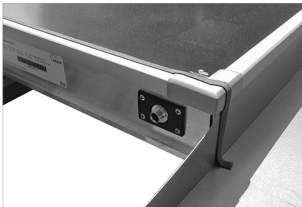
Abb. 79: Fugendichtband am oberen Rand über die ganze Breite aufkleben
