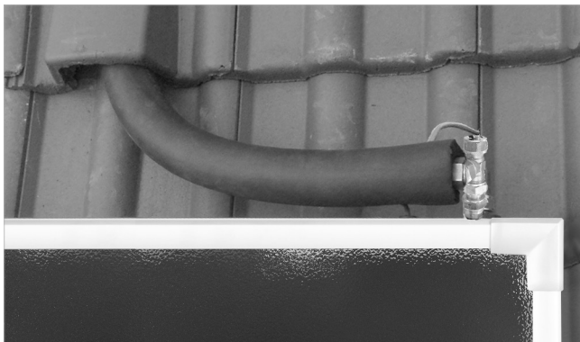
Abb. 94: Vorlauf anschließen
