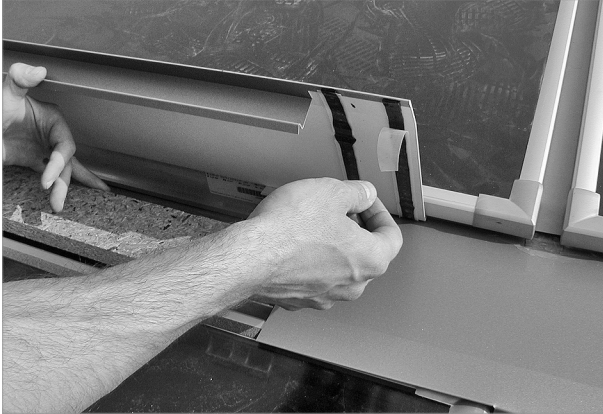
Abb. 75: Weitere Bleche montieren: Vor dem Auflegen Schutzstreifen abziehen
