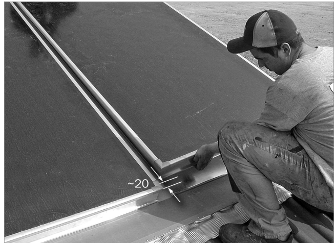
Abb. 54: Nächsten Kollektor aufsetzen und gegen das Halteblech nach unten schieben
