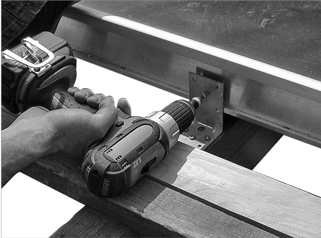
Abb. 51: An der oberen Stirnseite den Kollektor am Dachsparren fixieren
