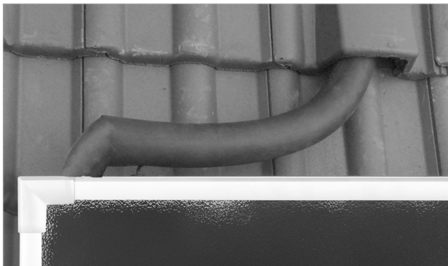
Abb. 93: Rücklauf anschließen
