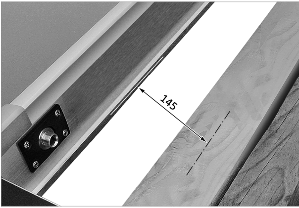
Abb. 60: Für weitere Kollektorreihe ggf. Zusatzschalung oberhalb des Kollektors anbringen
