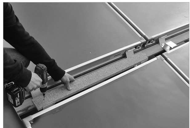
Abb. 68: Zwischenblechstützen auf Kollektordistanzstücke schrauben
