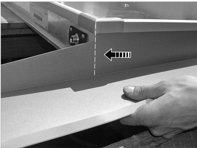
Abb. 65: Oberes Seitenblech gegen den Anschlag nach oben schieben
