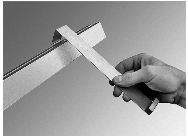
Abb. 20: Anschlaghaken einhängen (2 je Kollektor)
