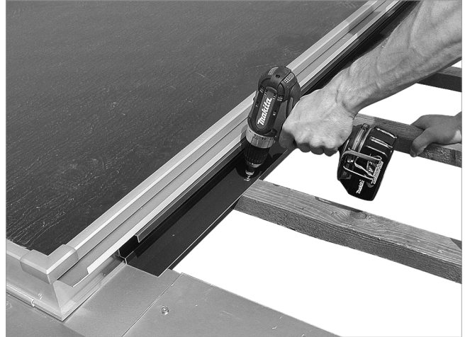
Abb. 53: Gegen den Anschlag nach unten schieben und mit den Dachlatten verschrauben
