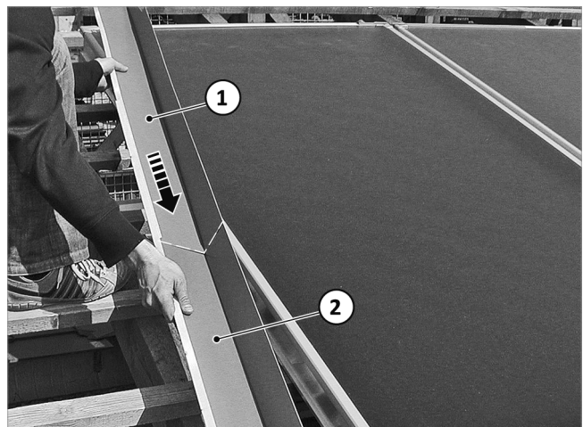
Abb. 63: Oberes Seitenblech über das untere schieben
