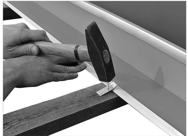
Abb. 67: Bleche mit Blechhaften an Dachlatten fixieren
