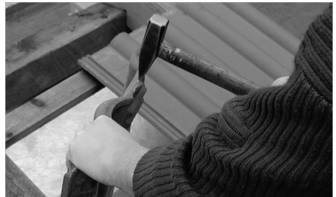
Abb. 87: Ggf. Haltenasen entfernen
