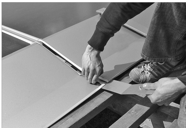
Abb. 81: Das untere Blech des Verbinders unter die Oberbleche schieben
