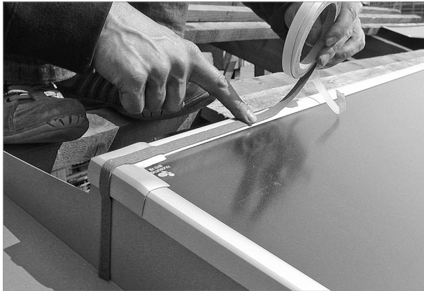
Abb. 69: Am oberen Rand Fugendichtband über ganze Breite aufkleben
