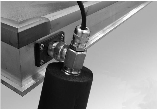
Abb. 92: Sensor montieren (Solar-Vorlauf)
