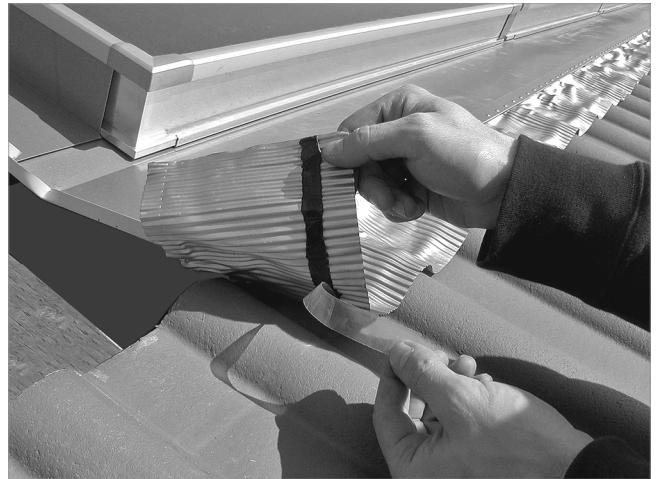
Abb. 49: Schutzstreifen abziehen und Bleischürzen andrücken
