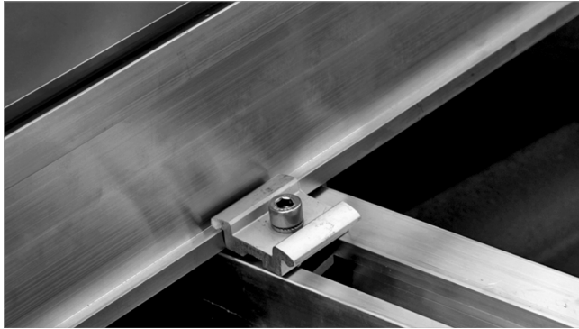
Abb. 41: Mittelklemmen zunächst lose angelegt
