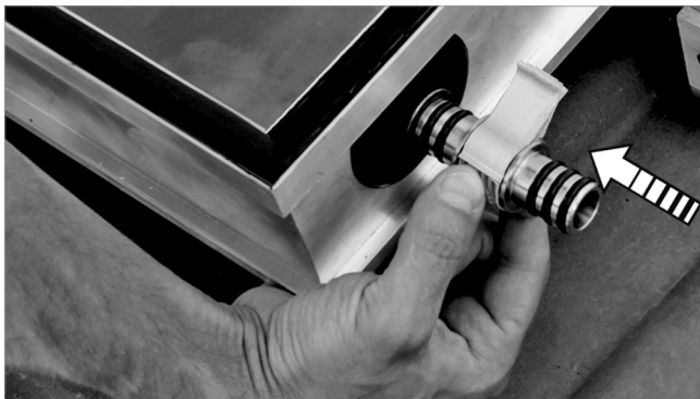
Abb. 42: Kollektorverbinder einstecken
