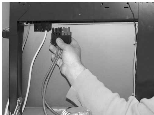
Abb. 36: Gebläsestecker abziehen
