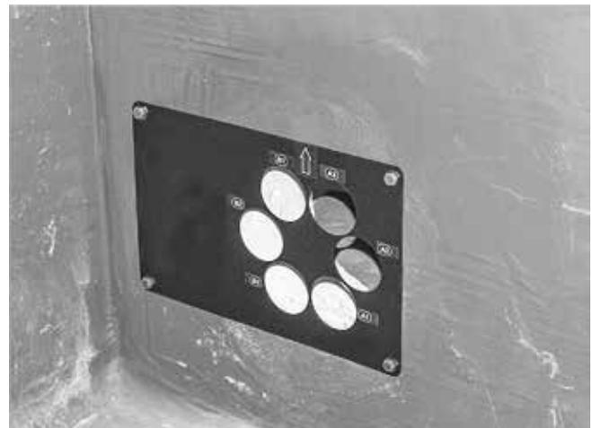
Abb. 18: Abdeckplatte im Lagerraum montiert
