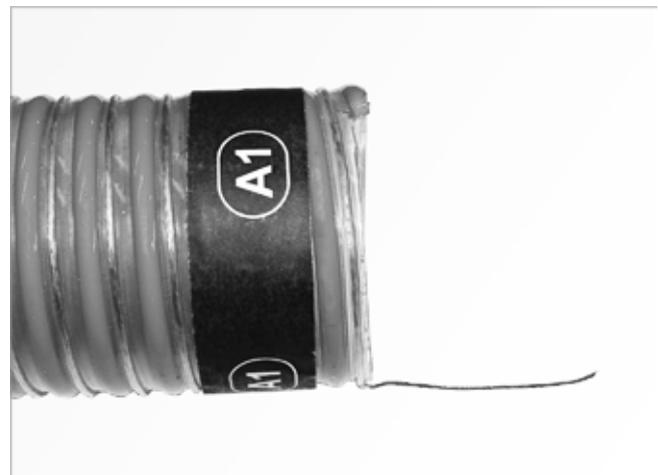
Abb. 19: Erdungsdraht freilegen, Schlauchende beschriften
