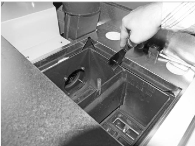
Abb. 160: Nachheizflächen reinigen
