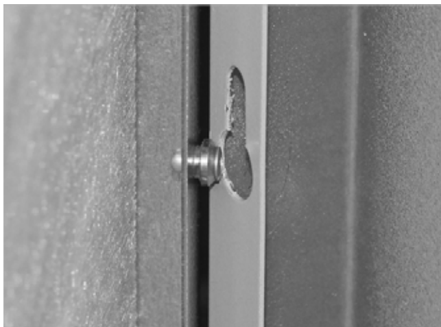
Abb. 86: Bajonettverschluss
