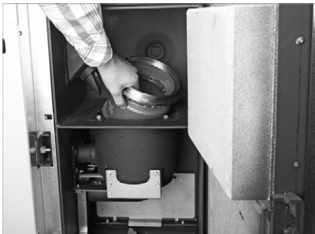
Abb. 145: Konus Unterteil herausheben
