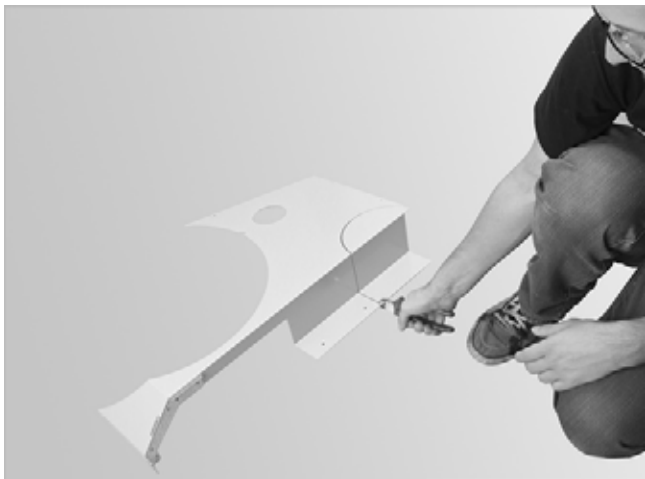
Abb. 75: Nur bei Abgasanschluss nach oben ausbrechen
