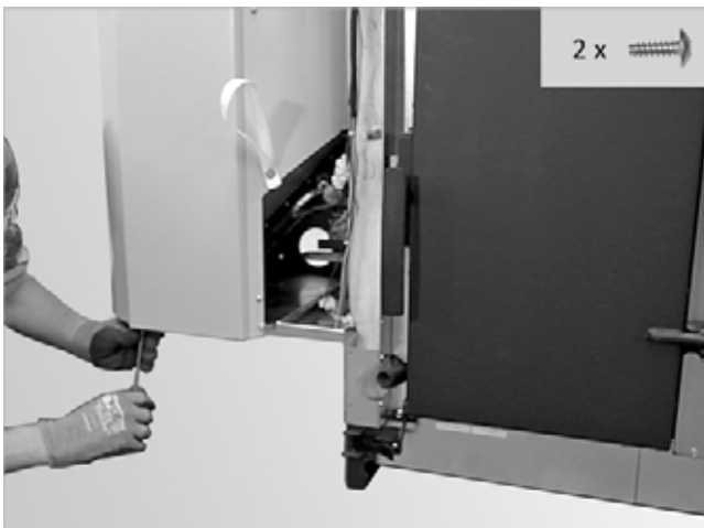
Abb. 169: Schrauben unten entfernen
