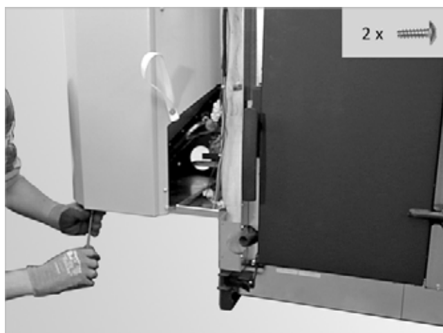
Abb. 32: Zwei Stück Schrauben entfernen
