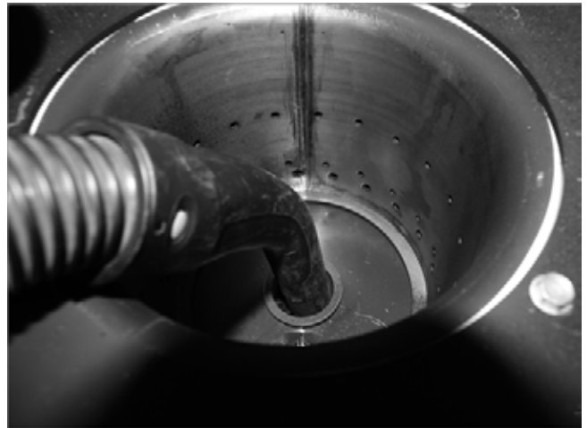
Abb. 152: Primärluftrohr aussaugen
