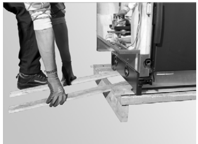
Abb. 7: Verschlagbretter an Rampe legen
