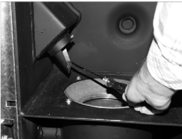
Abb. 142: Fallrinne reinigen
