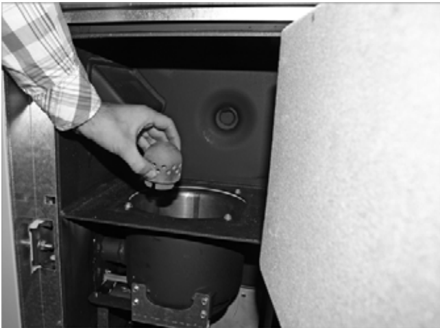
Abb. 149: Primärluftdorn entnehmen
