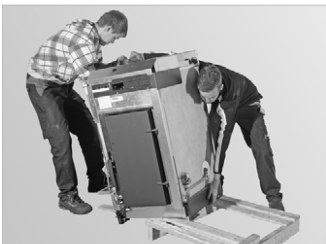
Abb. 9: Kessel von Palette schieben
