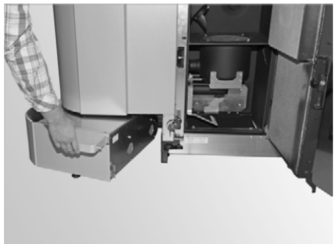
Abb. 135: Behälter leicht nach links drücken
