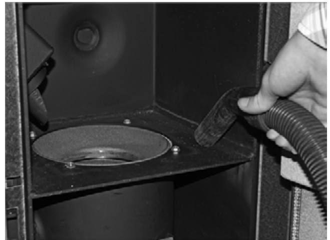
Abb. 143: Verbrennungsrückstände entfernen
