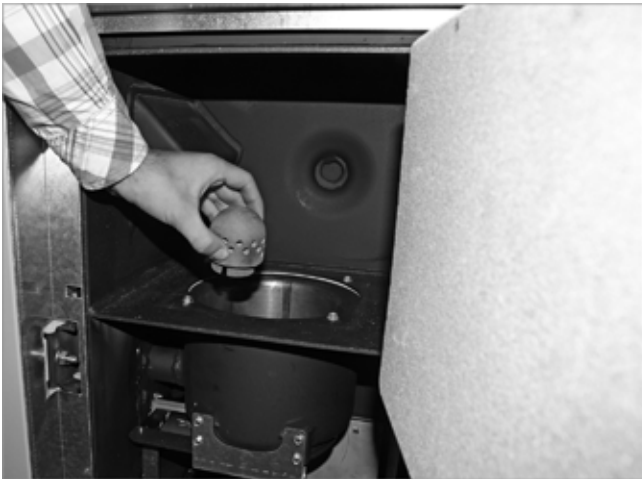
Abb. 151: Primärluftdorn entnehmen
