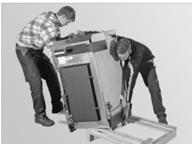
Abb. 9: Kessel von Palette schieben
