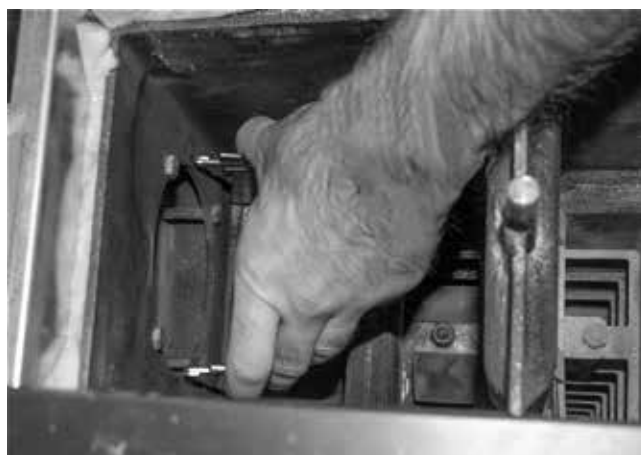
Abb. 163: Umlenblech herausnehmen
