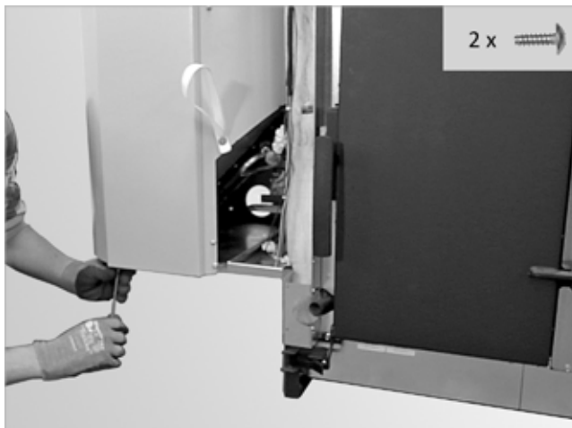
Abb. 39: Blende befestigen
