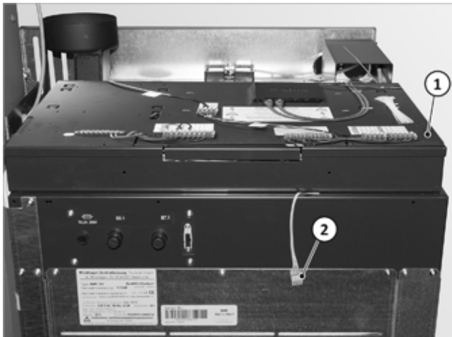
Abb. 69: Deckel vom Schaltfeld aufklappen
