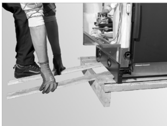
Abb. 7: Verschlagbretter an Rampe legen
