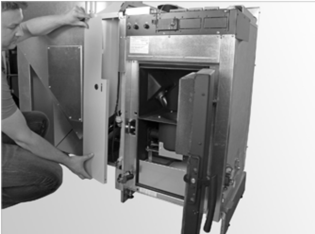
Abb. 78: Verkleidung vorne einhängen
