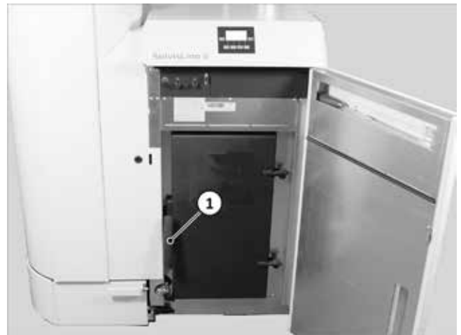
Abb. 128: Hebel (1) nach oben ziehen
