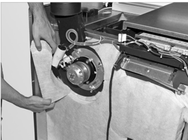
Abb. 21: Isolierung um Abgasgebläse entfernen
