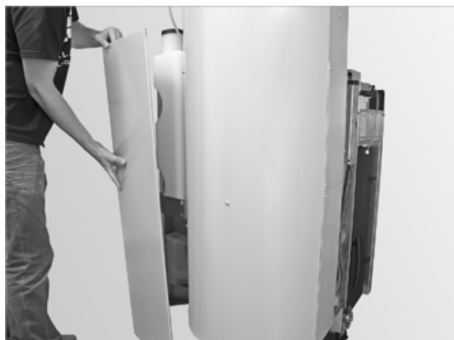
Abb. 44: Verkleidung einhängen
