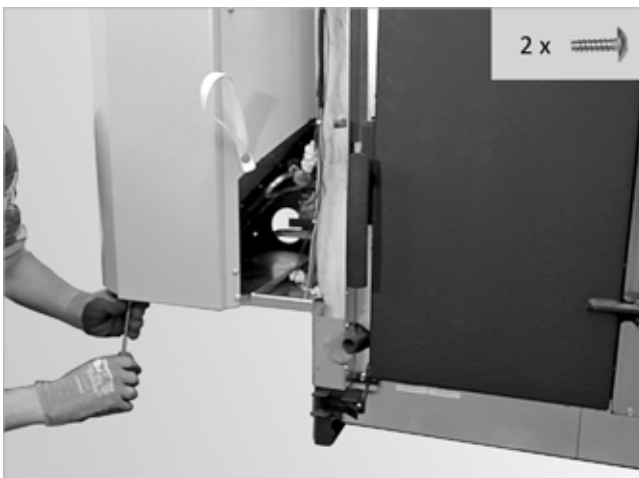
Abb. 32: Zwei Stück Schrauben entfernen
