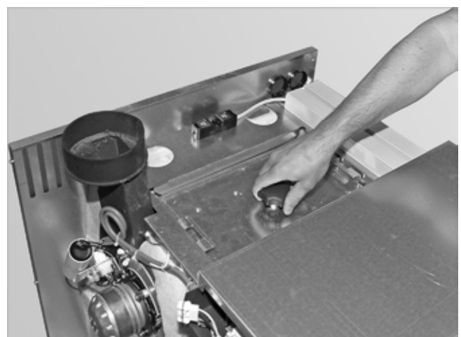
Abb. 18: Verschraubung entfernen
