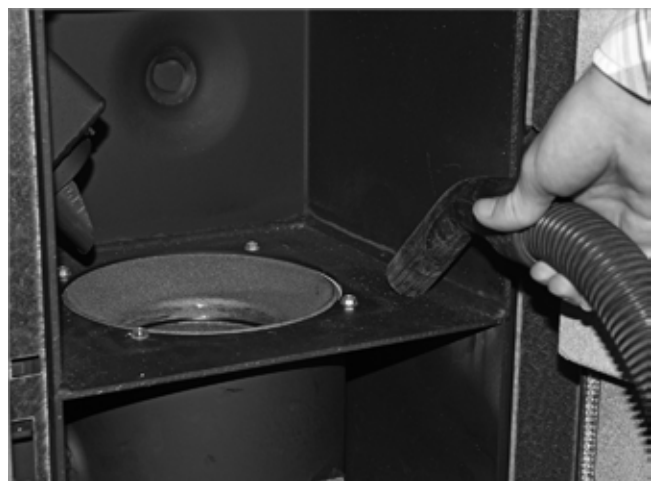
Abb. 31: Verbrennungsrückstände entfernen
