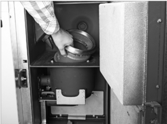
Abb. 33: Konus Unterteil herausheben
