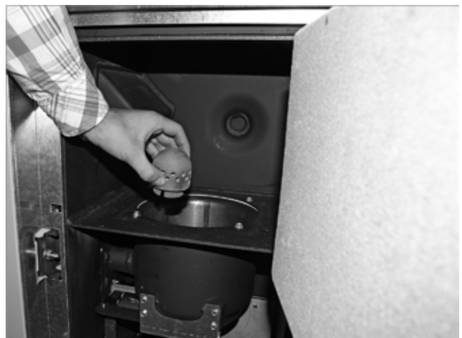
Abb. 37: Primärluftdorn entnehmen
