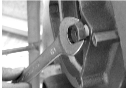
Bild 4: Tauchhülse einsetzen
